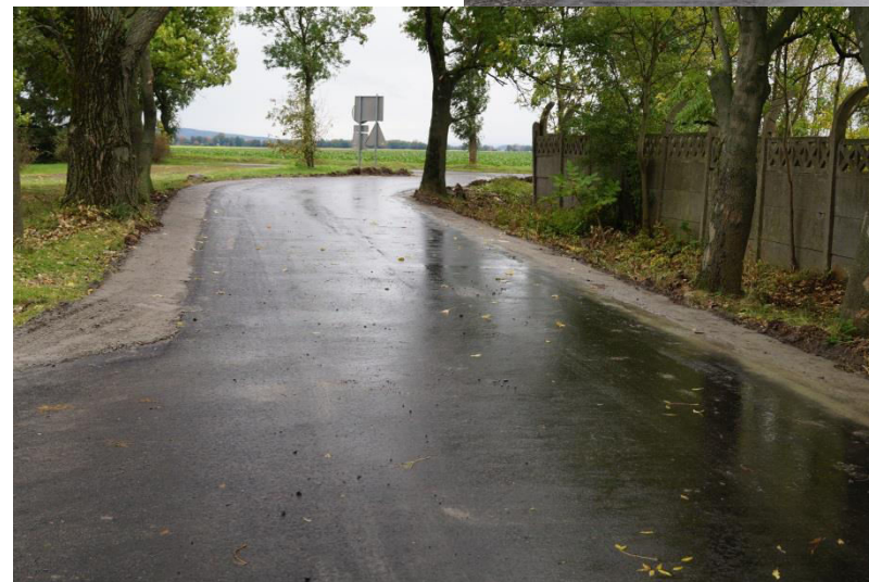
Po zakończeniu realizacji inwestycji
