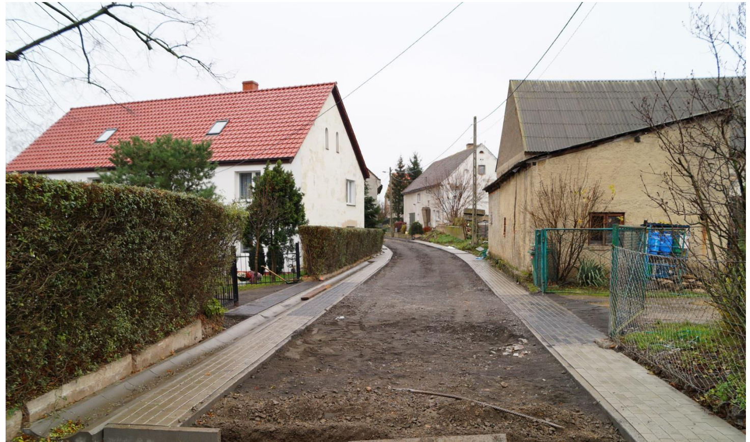
W trakcie realizacji inwestycji
