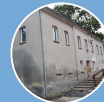
SŁUP - stan obecny Będzie nowy obiekt
